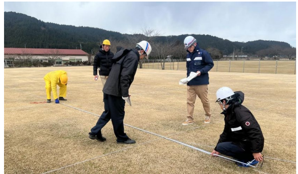
2月27日、工事着手前に配置を確認する地縄張りを石川県も立ち合い実施
