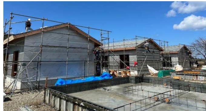
大工工事が始まり屋根作業に進む (町野)
