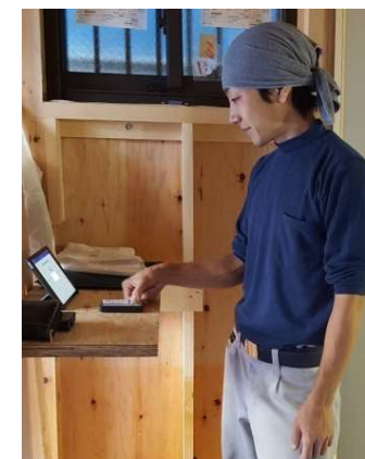
戸建住宅現場の屋内にiPadを設置
