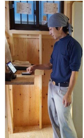
戸建住宅現場の屋内にiPadを設置
