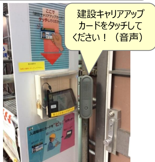
人感センサーによるスピーカーを設置して、技能者に自動呼びかけ
