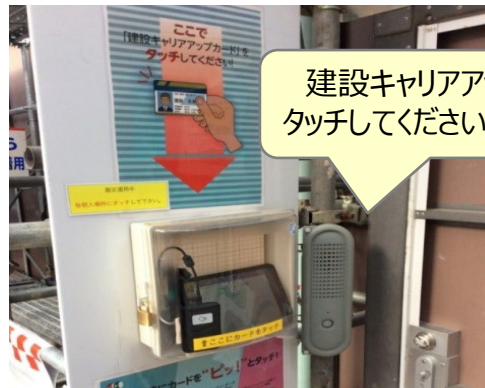
建設キャリアアップカードをタッチしてください！（音声） 人感センサーによるスピーカーを設置して、技能者に自動呼びかけ
