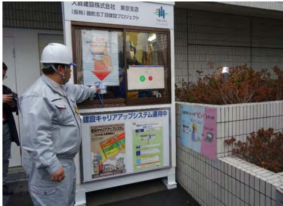
屋外のため、盗難防止や雨対策の観点から、ガードマンボックスを活用
